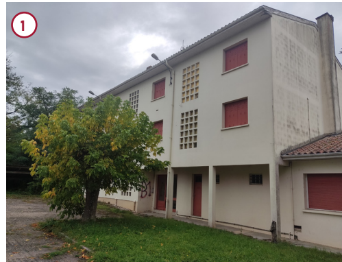
Gendarmerie de Gensac, site de projet de réalisation de logements sociaux
