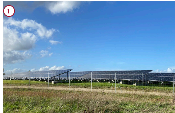
Un parc photovoltaïque à Rauzan
